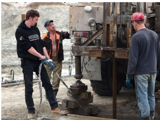
**Рисунок 9.** Опускание косы в скважину.
